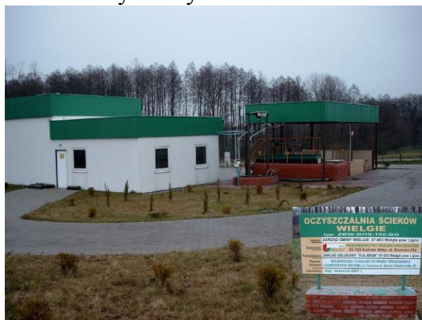
Oczyszczalnia ścieków w Wielgiem
