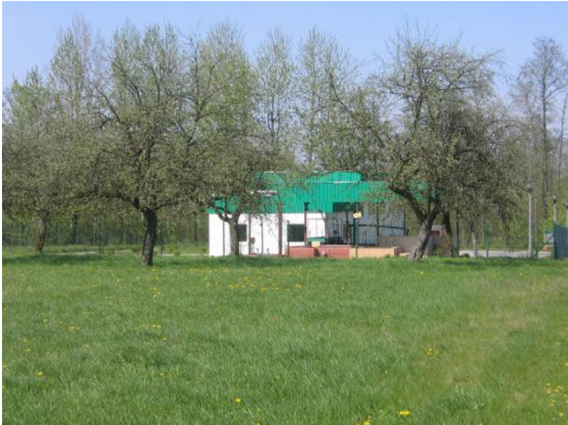
Fot. 5 Wielgie – gminna oczyszczalnia ścieków
