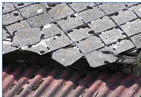
Rys. 8. Pokrycie dachowe ocenione w I stopniu pilności (źródło własne).
